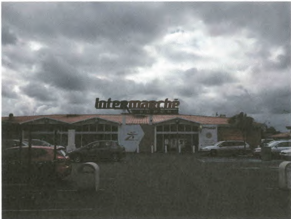
Enseigne sur toiture non conforme (avec un panneau de fond), Marcheprime, Octobre 2019
