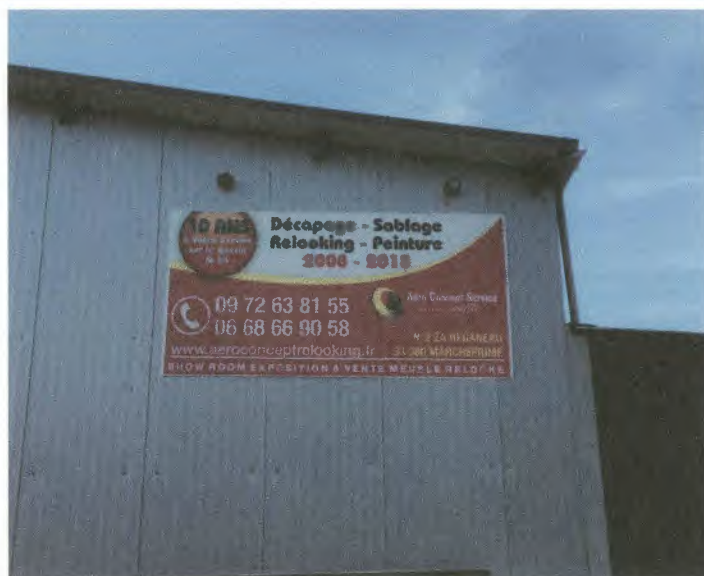
Enseigne parallèle au mur éclairée par projection, Marcheprime, Octobre 2019
